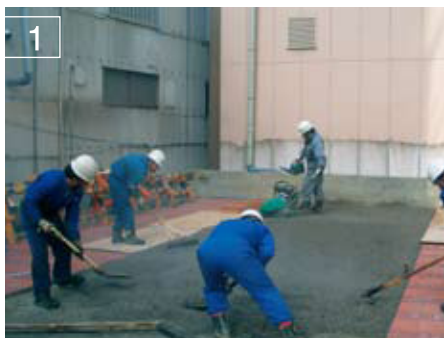
1 アスファルト混合物 舗設
